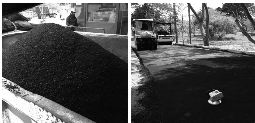
Figura 2. Construcción de tramo de prueba con aditivo multifuncional de Corasfaltos.
