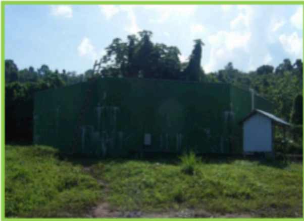
Tanque de almacén de 500 mil galones
