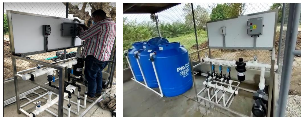
Figura 2. Instalación sistema de inyección manual de fertilizante de 3 vías.
