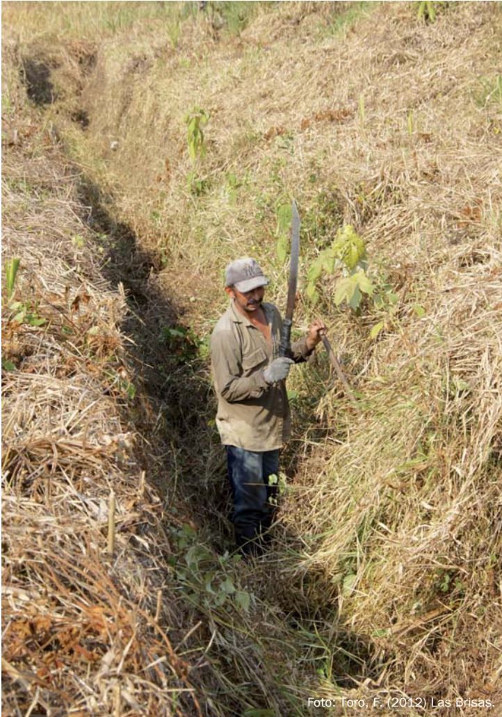
Corte y retiro de malezas del drenaje
