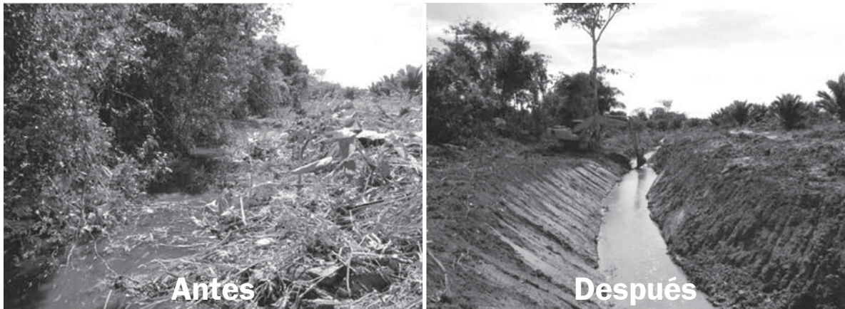
Figura 40. Detalle del trabajo del Proyecto Canalización Caño Las Marías, Campo Experimental Palmar de La Vizcaína.
