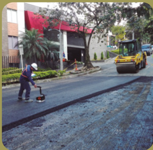
Figura 90. Tramos de prueba con asfalto aditivado con aceite de palma crudo
