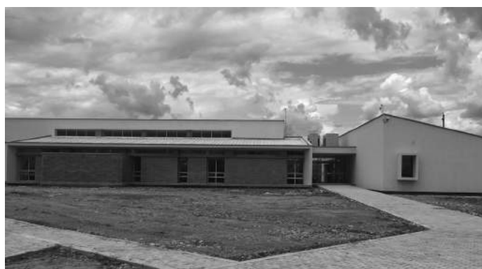
FIGURA 68. Vía y andenes exteriores de acceso al módulo de oficinas
