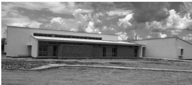
FIGURA 58. Fachada principal módulo de oficinas
