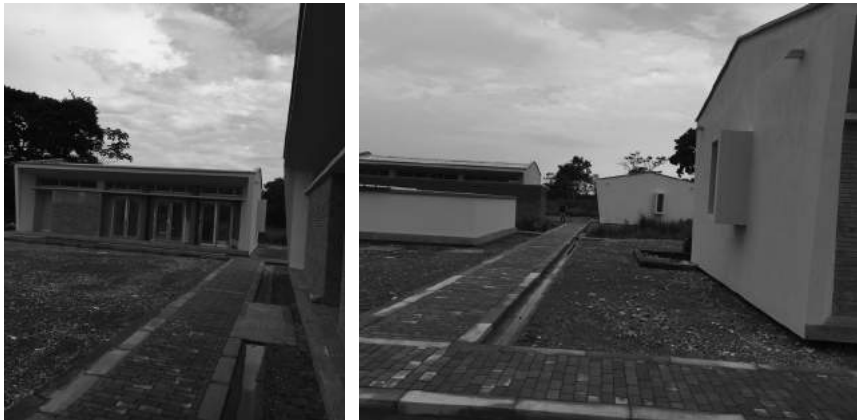
FIGURA 69. Área técnica sede principal
