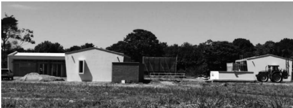
FIGURA 64. Vista general módulo de servicio al cultivo
