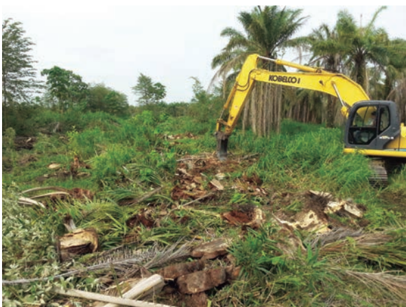
Erradicación mecánica (Retroexcavadora)
