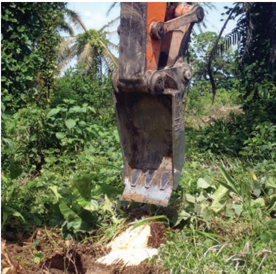
Figura 15: Erradicación mecánica por medio de una excavadora.
