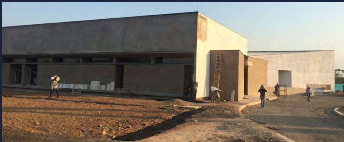
Figura 59. Fachada lateral – Vía interna de servicio
