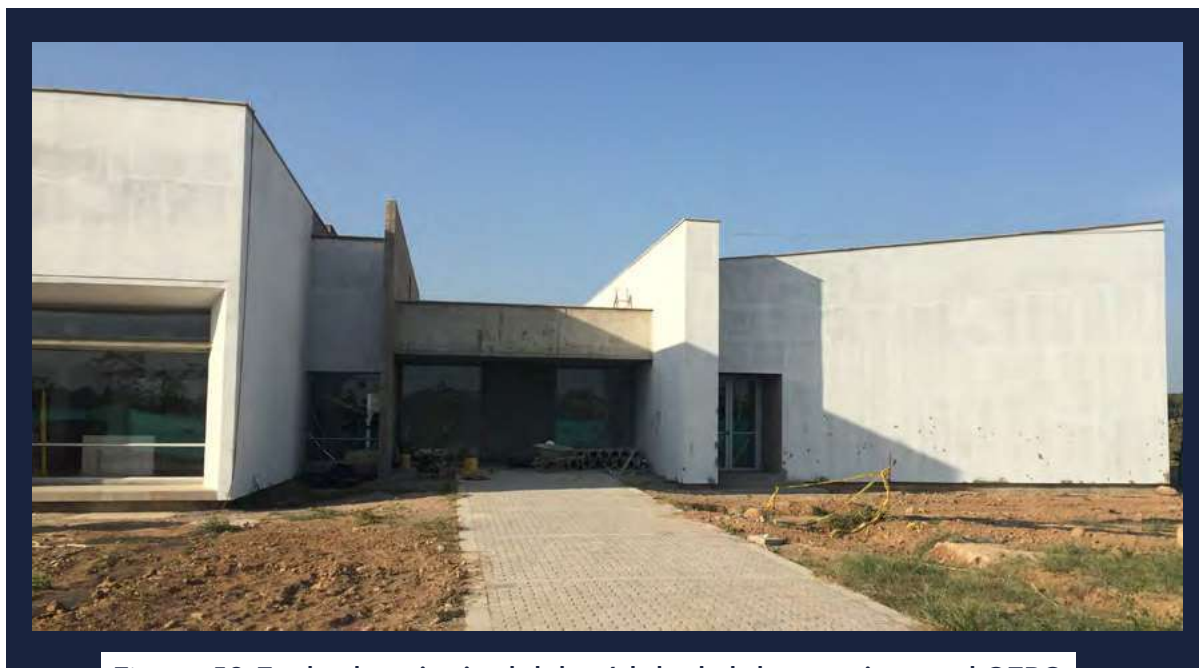
Figura 58. Fachada principal del módulo de laboratorios en el CEPC
